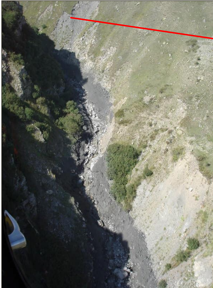
09/2006 : trois griffes d'érosion peu actives, pas de fissure apparente.
