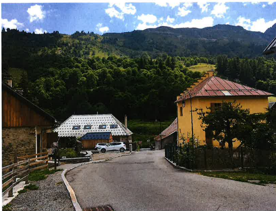
(1) Vue de la route de la Soupière - Implantation du Club med face au hameau des Verneys – la forêt rasée et remplacée par un complexe de 40 000m 2 (5 bâtiments !)
